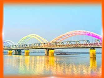
สะพานรถไฟปินโจว
