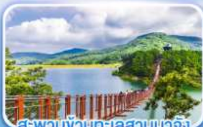
สะพานขี้เหล็กทะเลสาบมาจิง
